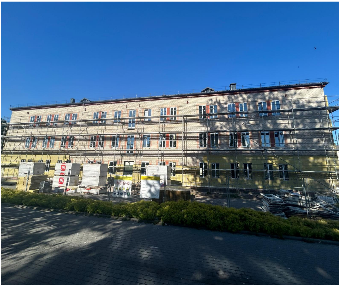
3.3.7. att. Esošās ēkas (siltināšanas laikā) dienvidu fasāde
