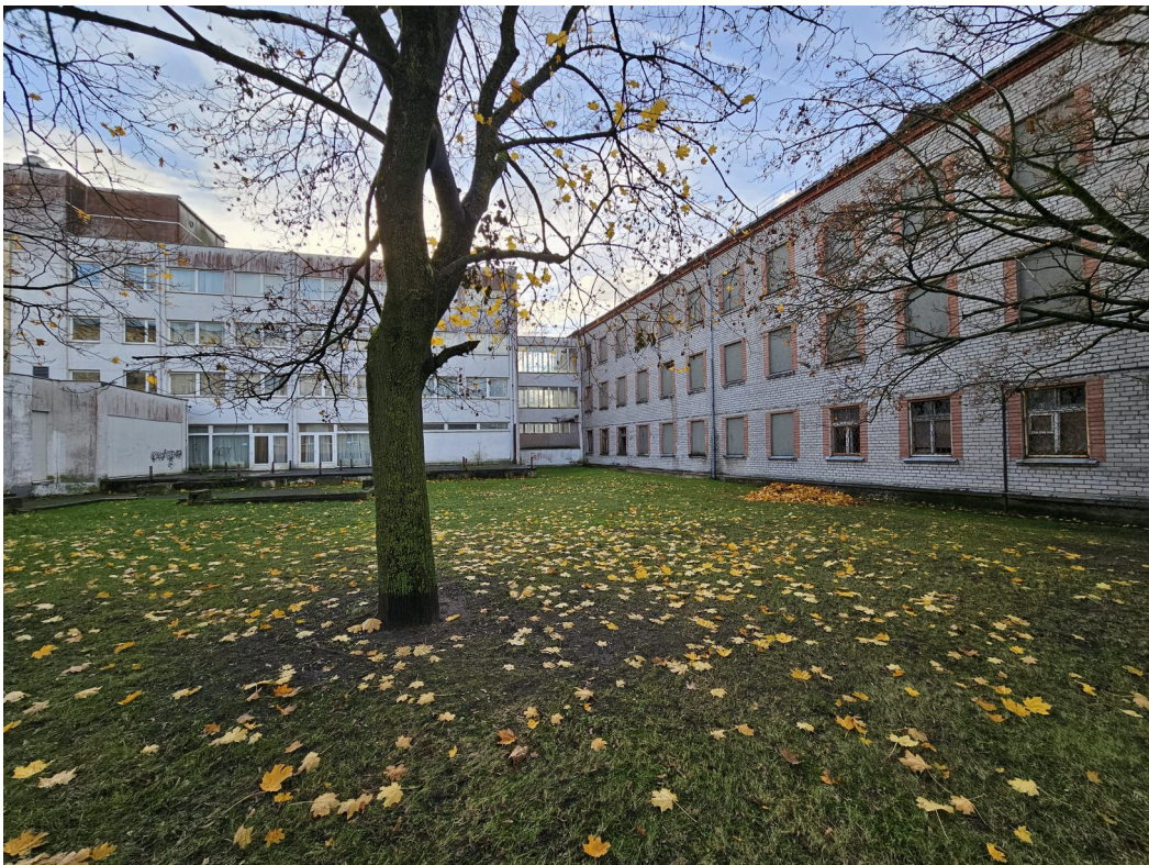
3.3.5. Esošās ēkas (pirms renovācijas) ziemeļu fasāde, ar ēku Talsu ielā 5, t.sk. pārejas gaiteni
