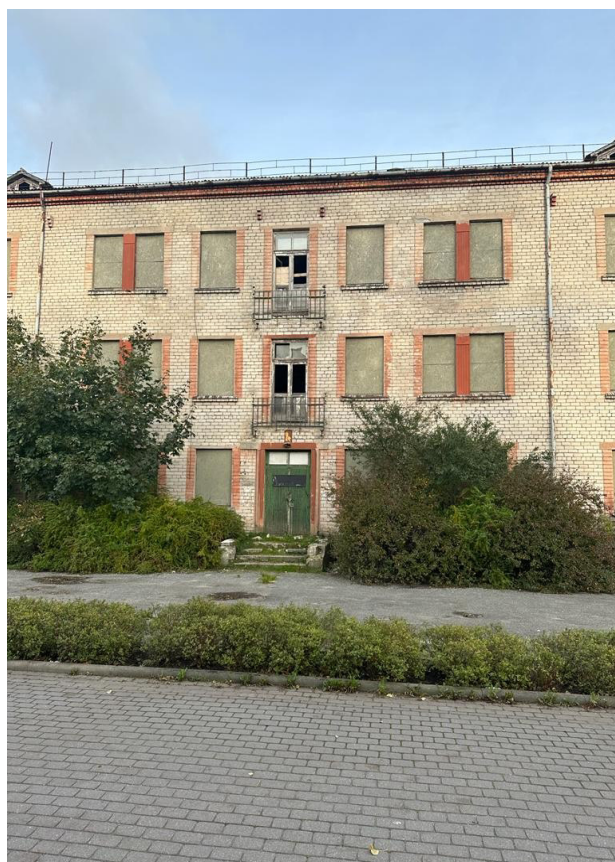
3.3.3.att. Esošās ēkas (pirms renovācijas) dienvidu fasāde
