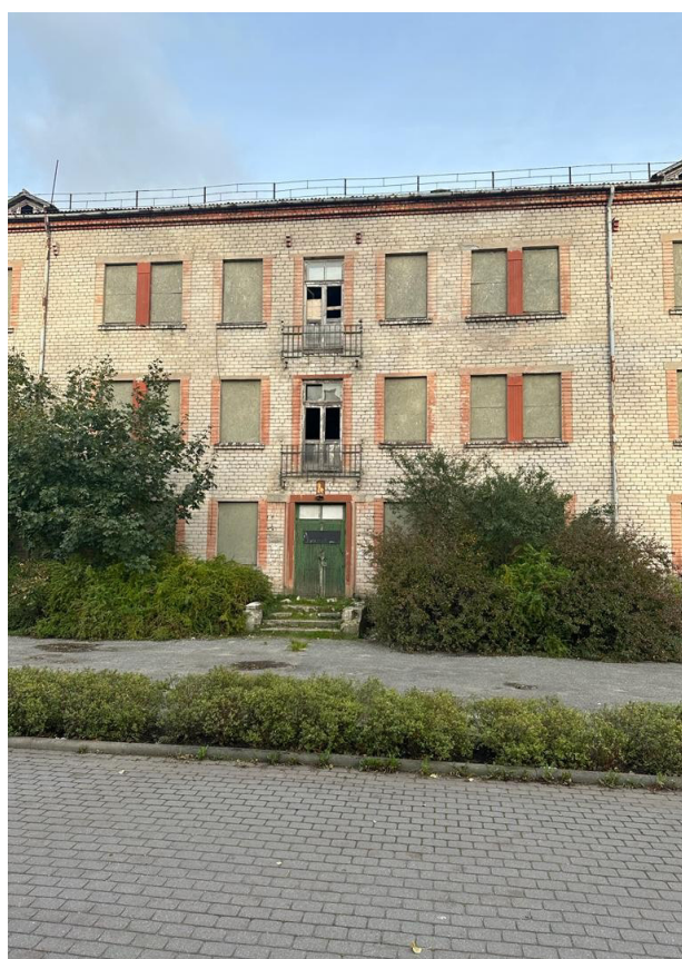
3.3.3.att. Esošās ēkas (pirms renovācijas) dienvidu fasāde
