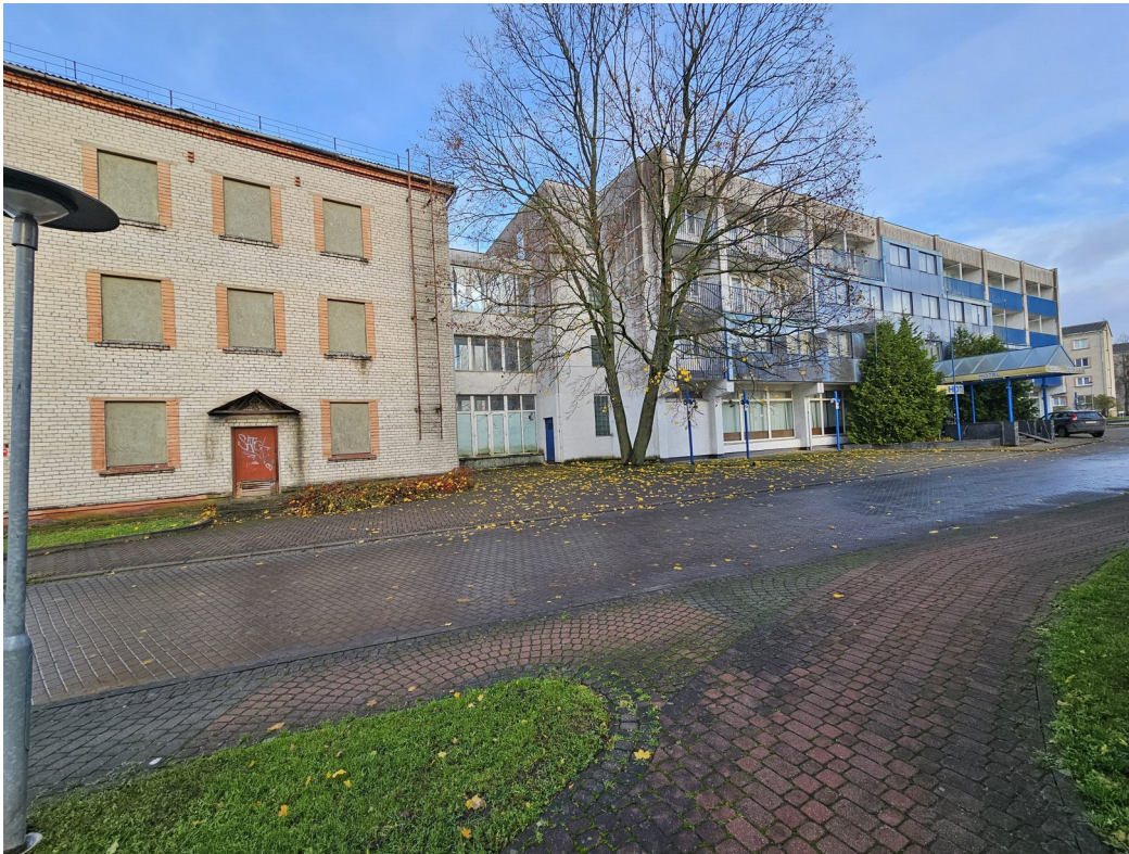
3.3.6.att. Esošās ēkas (pirms renovācijas) austrumu fasāde, ar ēku Talsu ielā 5, t.sk. pārejas gaiteni
