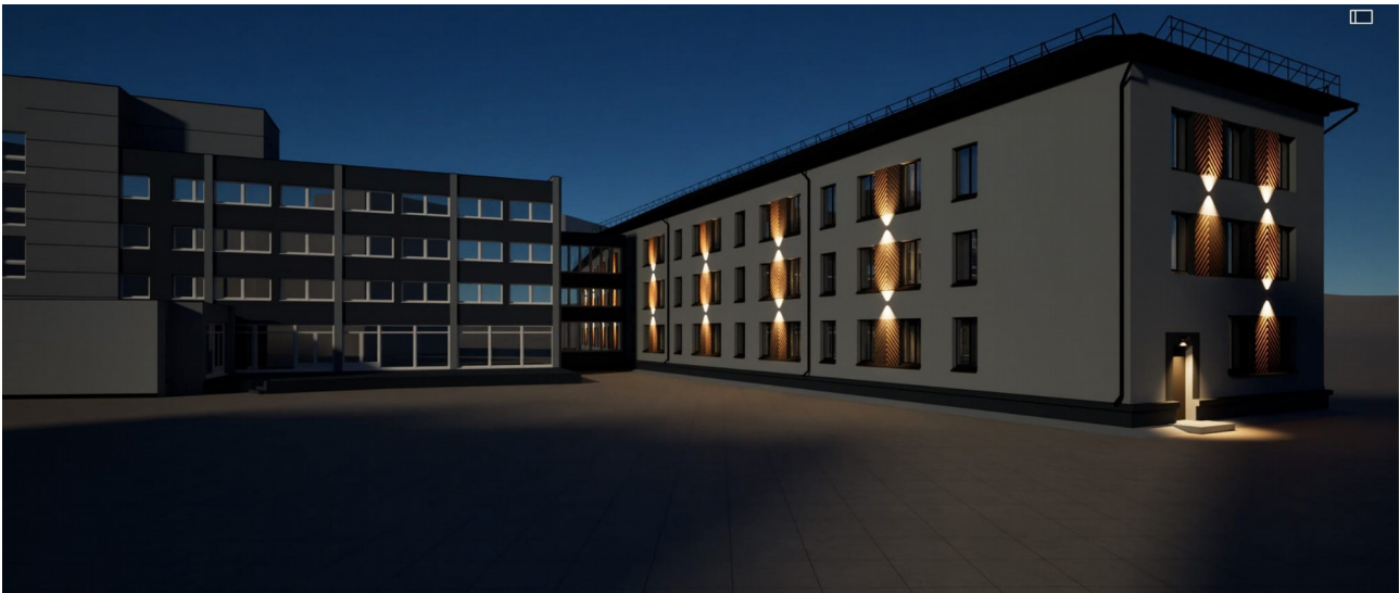
7.1.1.att. Daudzdzīvokļu ēka Talsu ielā 3A
