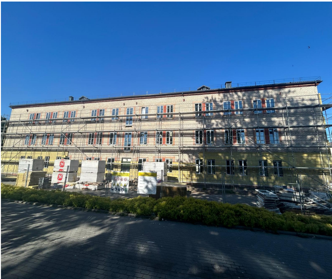
3.3.7. att. Esošās ēkas (siltināšanas laikā) dienvidu fasāde
