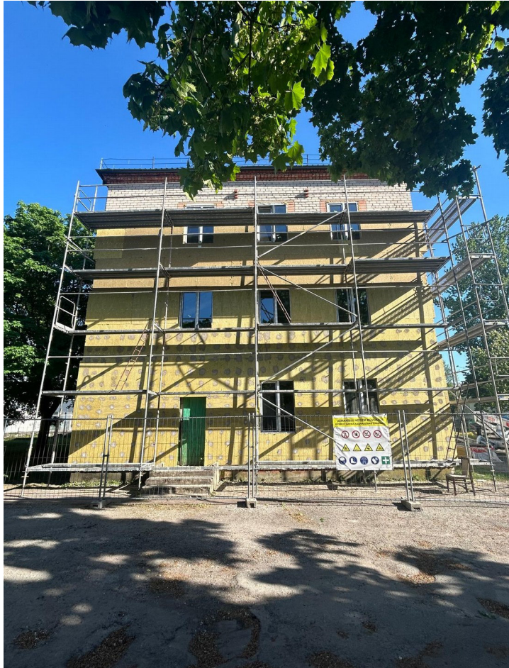
3.3.8.att. Esošās ēkas (siltināšanas laikā) rietumu fasāde
